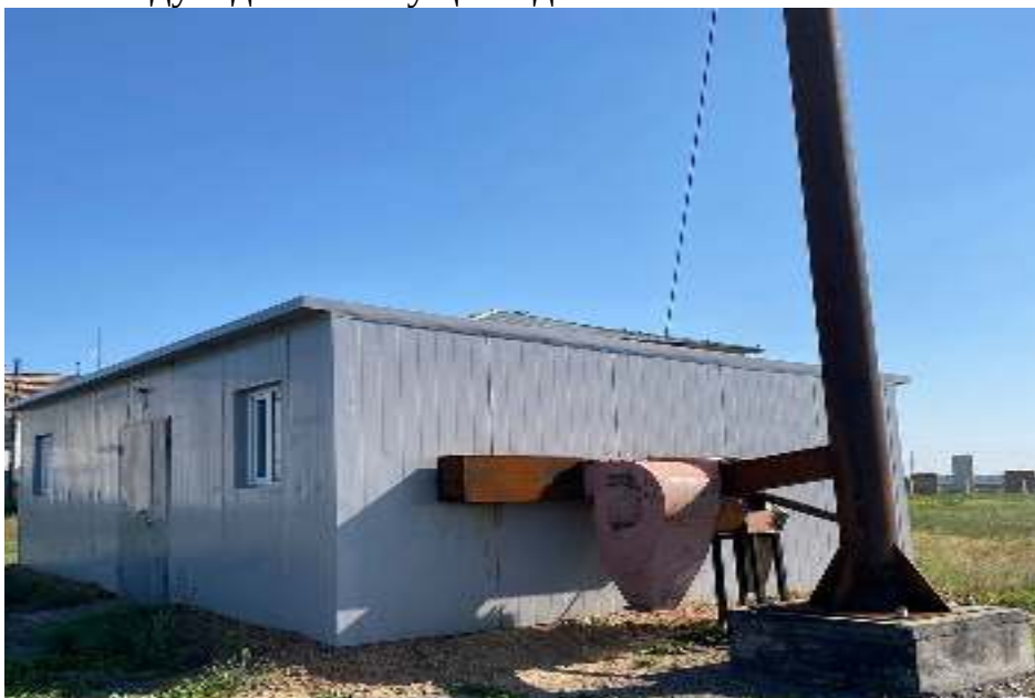
Блок-модульдік от жағу қазандығы
